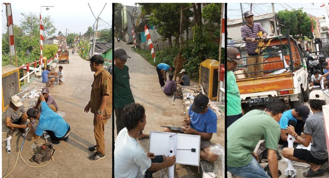
Gambar 3. Proses Pemasangan Lampu PJU berbasis Solar Panel
