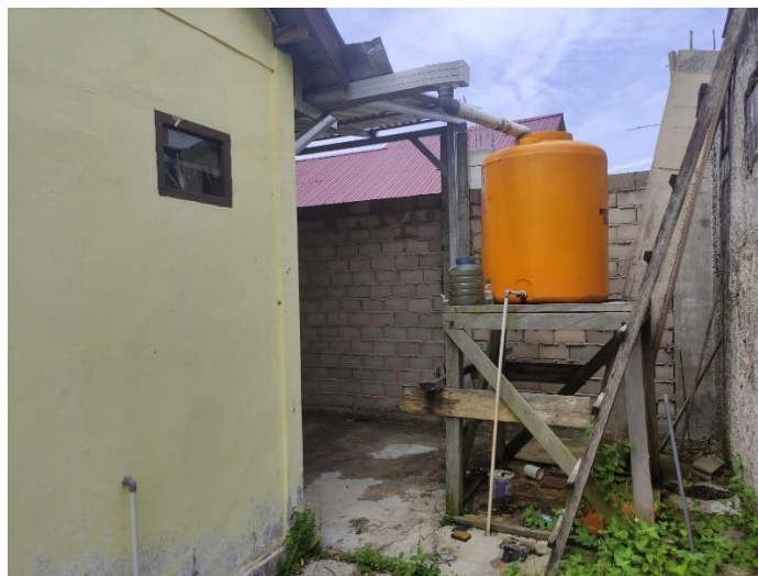
Gambar 3. Tandon Air Kapasitas 600 Liter yang Berfungsi Menyimpan Air Hujan yang Dipanen dari Daerah Tangkapan Air.
