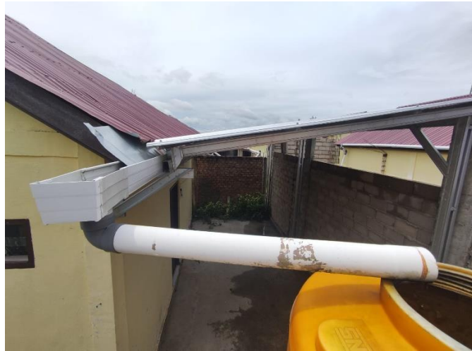
Gambar 2. Daerah Tangkapan Air berupa Atap yang Mengerucut Kebawah.
